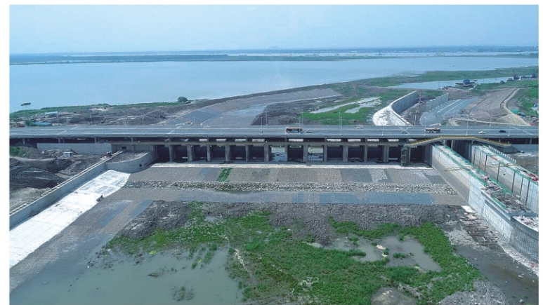
芜湖市澧港闸(桥)工程
