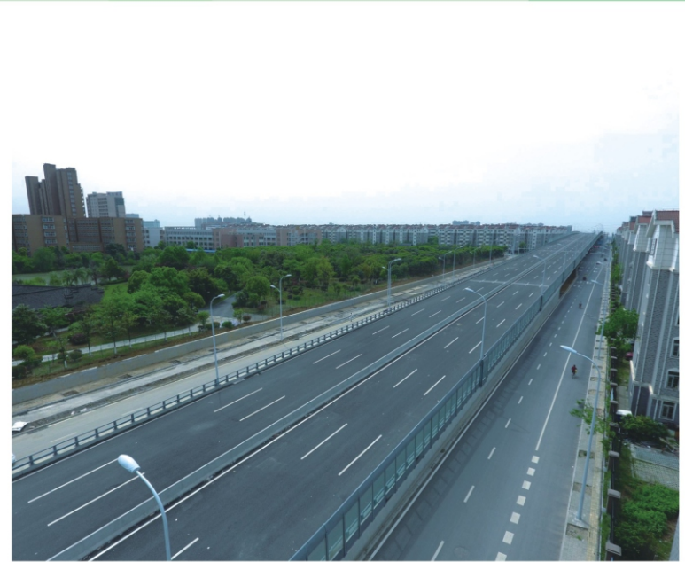
合肥市上海路工程
