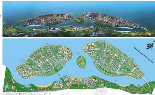
④ 蓬莱西海岸线修复护岸工程
