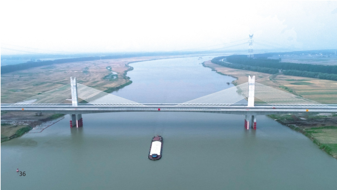
济祁高速淮河特大桥-主桥
